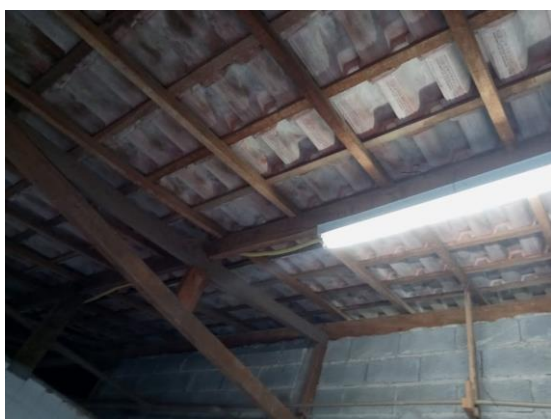
Figura 34: Teto do banheiro feminino (antes)
