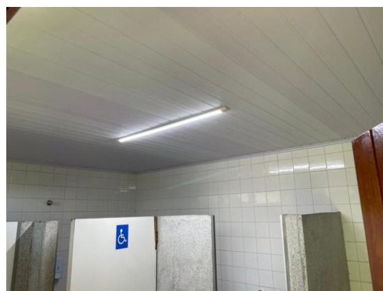
Figura 35: Teto do banheiro feminino (depois)
