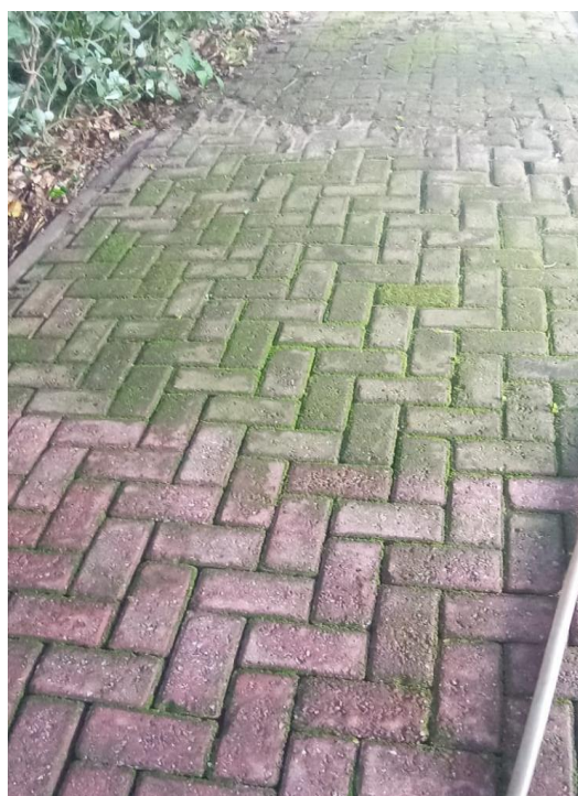
Figura 32: Lavagem do piso intertravado
