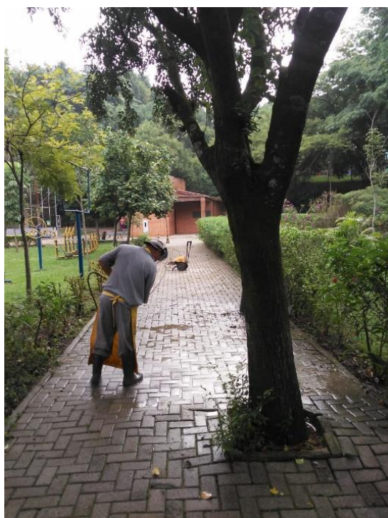
Figura 31: Lavagem do piso intertravado
